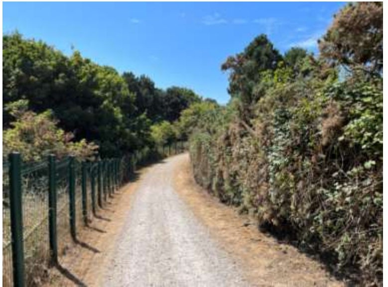
Figure 59 - Réseau de voirie gravillonnée et clôture rigide
