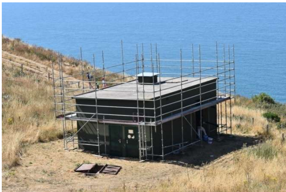
Figure 142 - Regard du compteur devant le bâtiment du captage des Pisseuses
