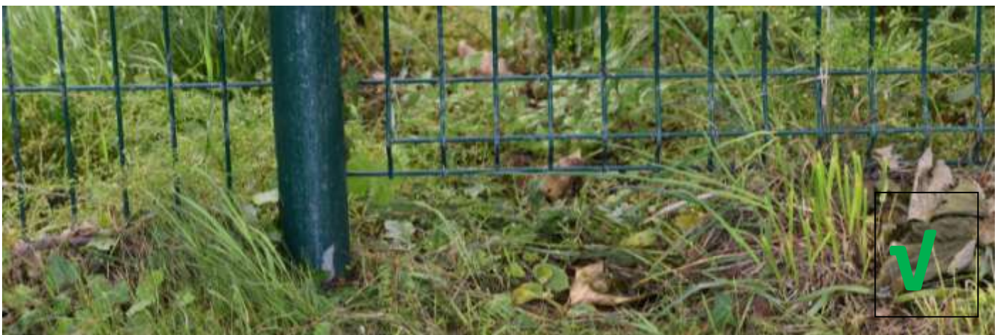
Figure 141 - Passage créé par une simple dépression dans le sol, permettant à la petite faune de circuler.
